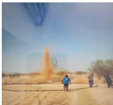
بعد عملية الحفر نرى كيف ينفجر الماء فوق سطح الأرض ومدى قوته.
